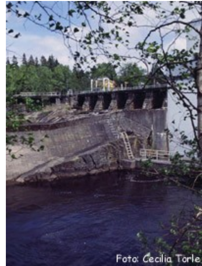
Ängabäcks kraftverk i Lagan
